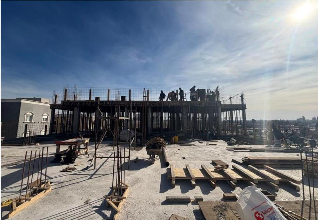
*Vista. LOSA SECTOR A y C – TERRAZA. Preparado de encofrados.*
